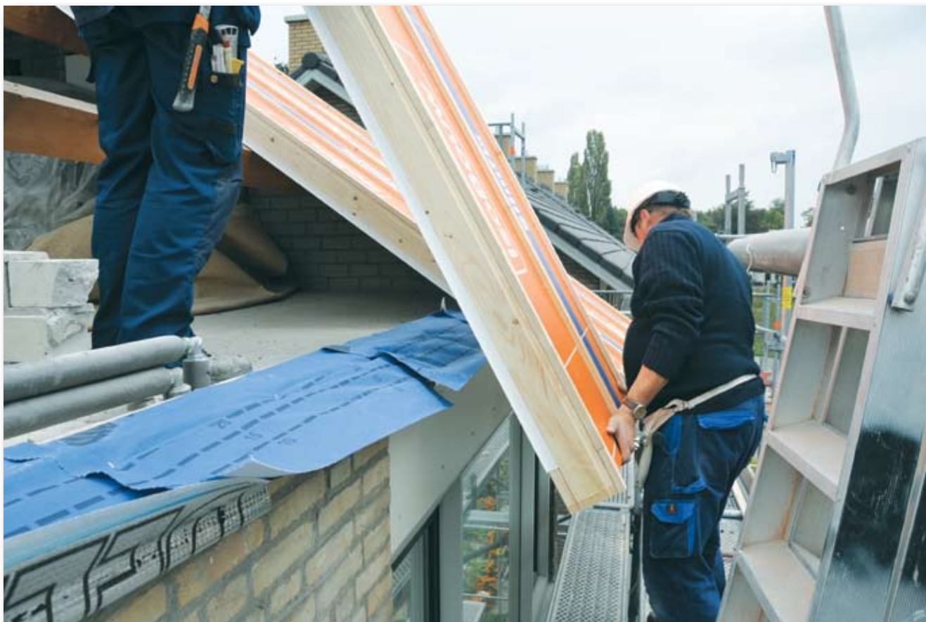
Het dakvoetprofiel in de praktijk.
