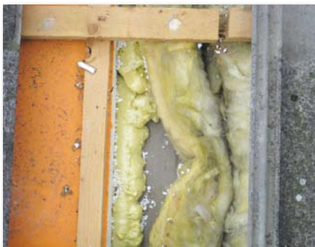
Wanneer spouwmuurisolatie zonder onderbreking onder de pannen eindigt, ontstaat een ongewenst vochttransport.
