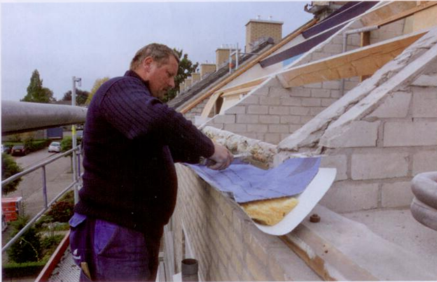
De dakvoetruips wordt aangebracht op de muurplaat....
