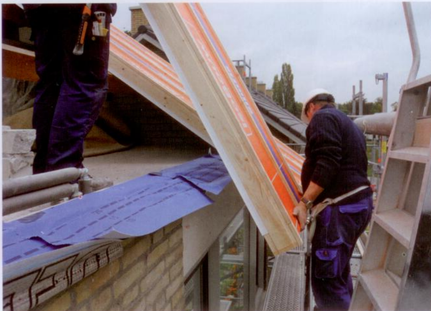
.....het prefab dakelement wordt geplaatst.....
