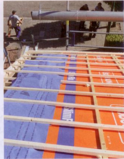
Een Bouwrups als verbinding tussen een kopgevel en de geïsoleerde kap.
