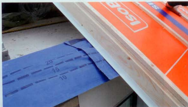
... en legt daar een dakplaat op.
